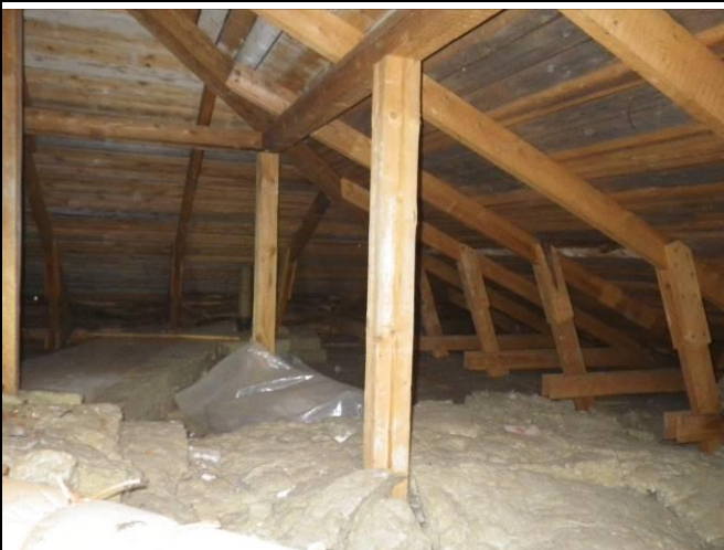
Kuva 10.1 Yleiskuva eteläsiiven yläpohjasta.
