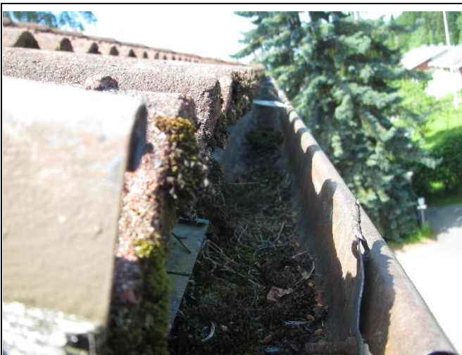
Kuva 11.3. Räystäskourussa on ylimääräistä kasvustoa.
