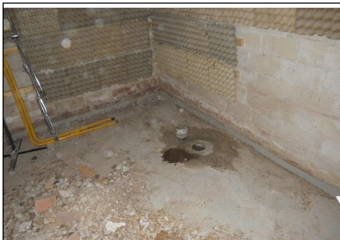
Kuva 6.1 Yleiskuva kellarin ulkoseinästä.
