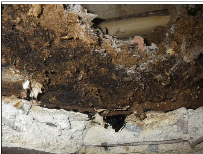
Kuva 8.5 Kutterit ovat mikrobivaurioituneet.
