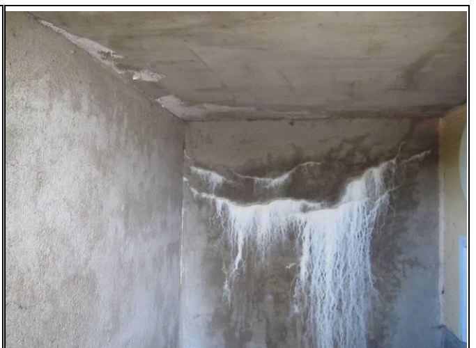
Kuva 7.6 Kellariin johtavan sisäänkäynnin ulkoseinä.
