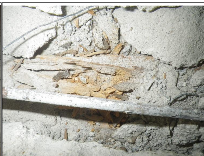
Kuva 8.2 Lahovaurioita rakenneavauksessa RA.13-VP
