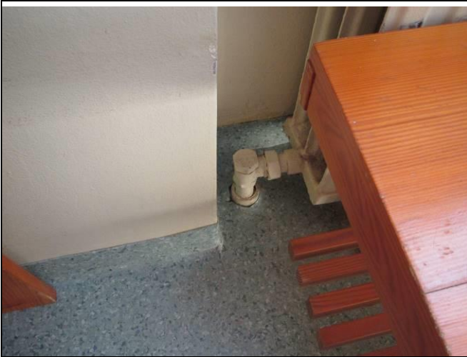
Kuva 8.9 Patterin läpiviemi on epätiivis.
