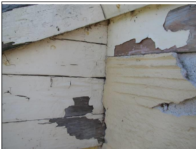
Kuva 9.5 Ulkoseinissä on irronneita pinnoitteita.
