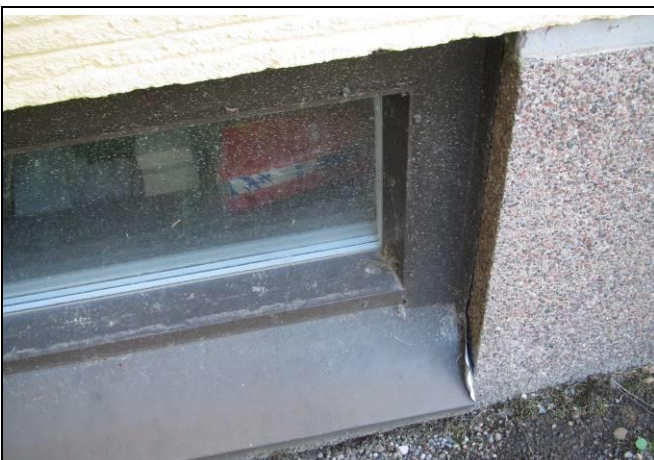
Kuva 5.3 Alakerran ikkunalla on matala sijainti ja pellitysongelma.
