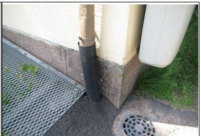
Kuva 5.4 Sadevesikaivo ja rännin ohjaus kaivoon.
