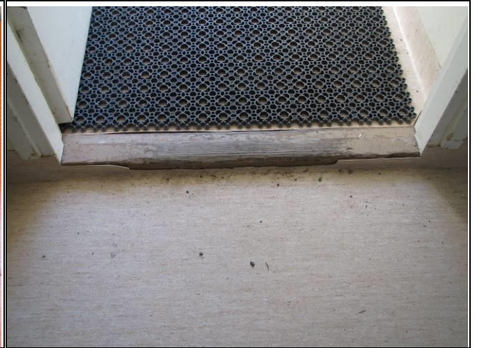
Kuva 8.10 Muovimatto on rikkoutunut kynnyksen reuna- nasta.
