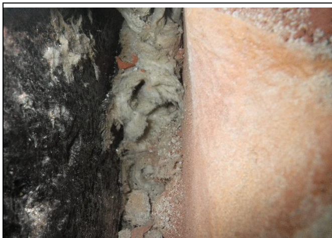
Kuva 6.5 Kuva ulkoseinän eristetilasta, RA.02-US.
