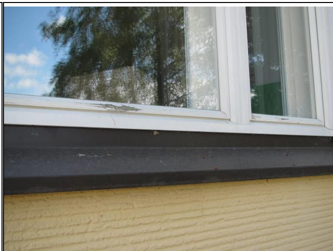
Kuva 9.8 Maali hilseilee ikkunankehiksestä.
