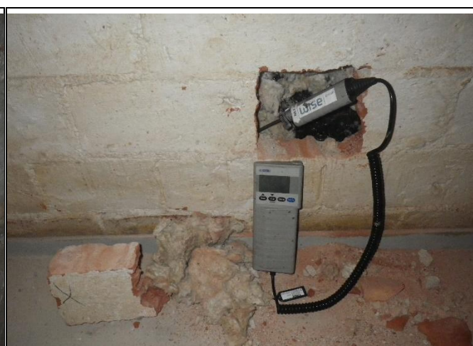
Kuva 6.4 Kosteusmittaus villatilasta, RA.02-US.
