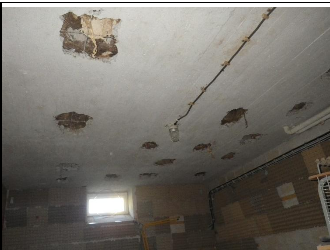
Kuva 8.6 Välipohjaan on tehty lukuisia kuivatusreikiä.
