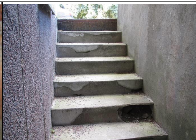
Kuva 6.6 Alakertaan johtavat maanvastaisessa seinä- mässä kiinniolevat vaurioituneet rappuset.
