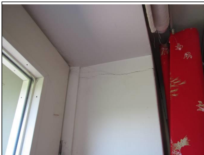
Kuva 9.9 Sisäpuolen seinärakenteissa on halkeamia.
