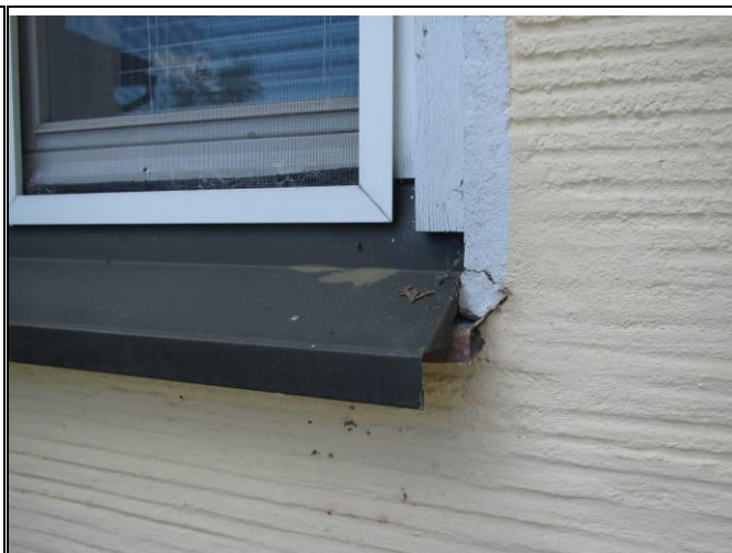
Kuva 9.6 Ikkunan nurkassa on lohkeama.
