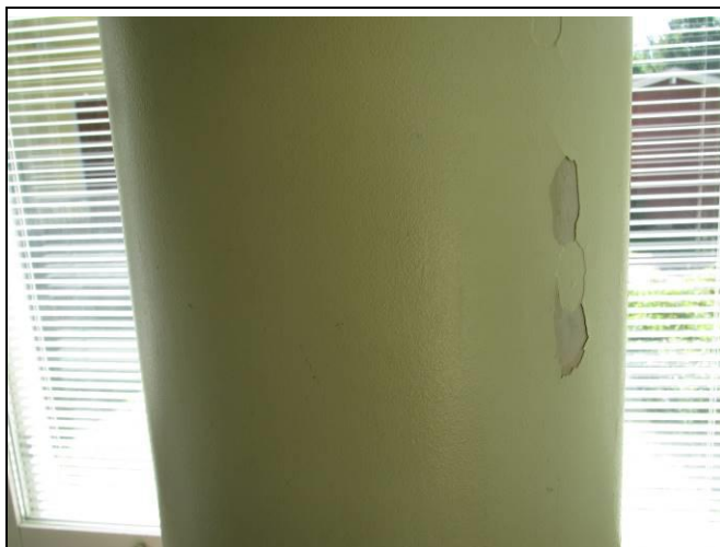
Kuva 9.11 Ulkoseinän sisäpinnan maalipinnoitteessa on lohkeamia.
