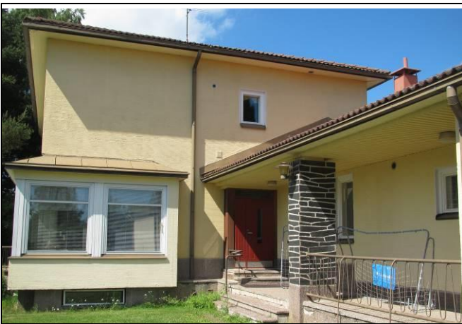
Kuva 5.1 Rakennuksen vierustasta yleiskuva, sisäänkäynti.
