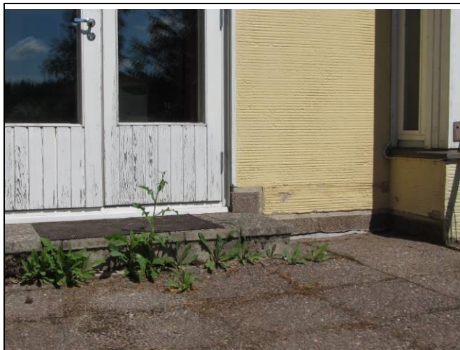
Kuva 9.7 Seinän alareunassa ja ovissa on kosteusrasituksen jälkiä.
