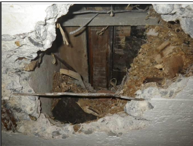
Kuva 8.4 Lahoa muottilaudoitusta on havaittavissa alapuolelta katsottuna.
