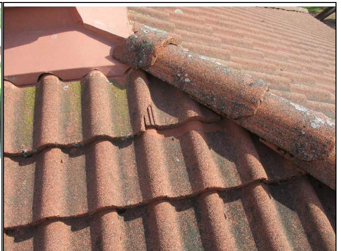
Kuva 11.4. Katolla on lohjenneita tiiliä.
