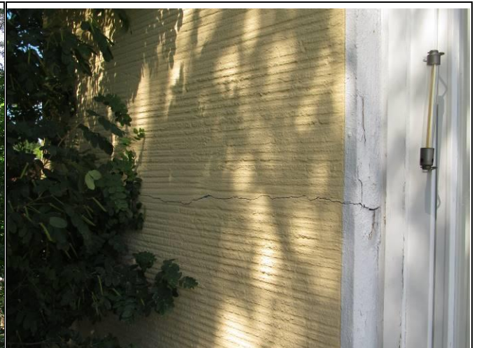
Kuva 9.4 Pinnoitteessa on halkeamia.
