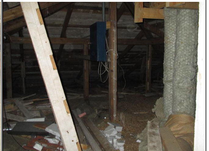
Kuva 10.4 Yläpohjassa on ylimääräistä roskaa.
