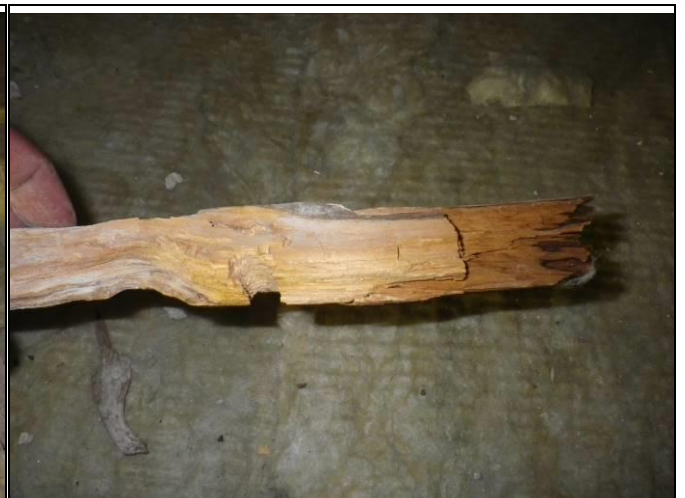
Kuva 10.6 Lahovauriota tukilautoituksessa, RA.16-YP.
