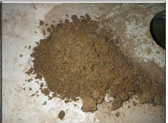
Kuva 7.4 Maa-aines lattiarakenteiden alla, RA.01-AP.
