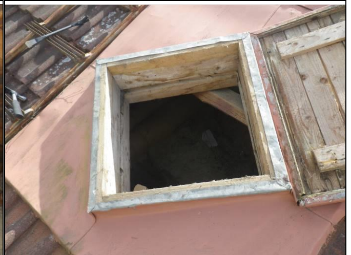
Kuva 10.2 Käynti yläpohjaan tapahtuu katolta huoltoluukun kautta eteläsiivessä.
