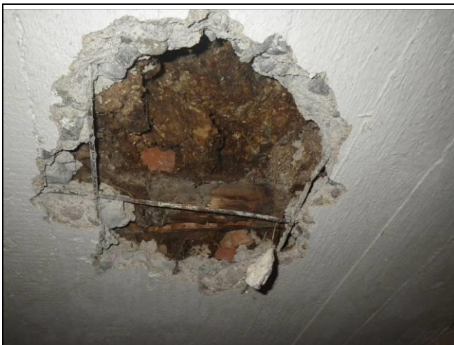
Kuva 8.3 Kutteri on tummaa ja kosteaa alapuolelta katsottuna.
