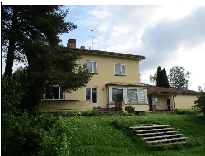
Kuva 11.7. Suuri mänty aiheuttaa katon roskaantumista.
