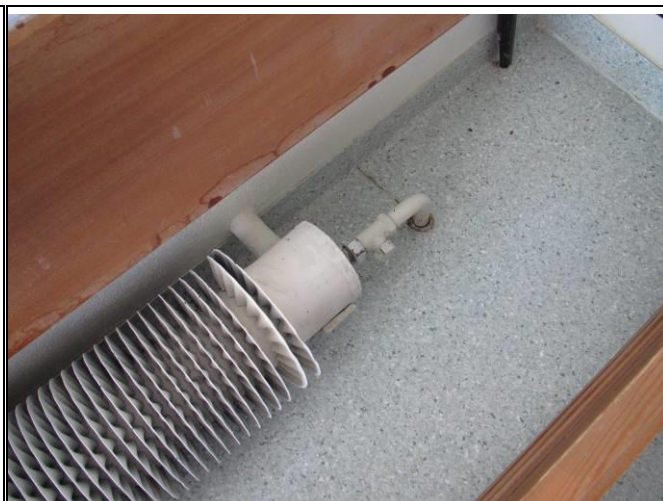
Kuva 9.10 Sisäpuolen seinärakenteissa on kosteusjälkiä.
