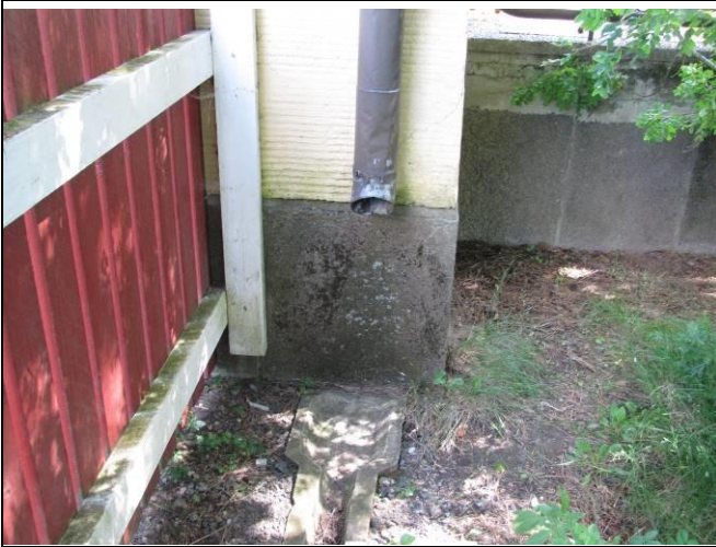
Kuva 5.5 Sadevesi laskeutuu seinustalle pintakourusta huolimatta.
