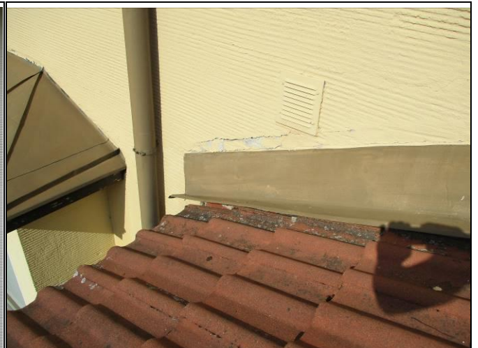
Kuva 9.2 Pinnoitteessa on lohkeamia.
