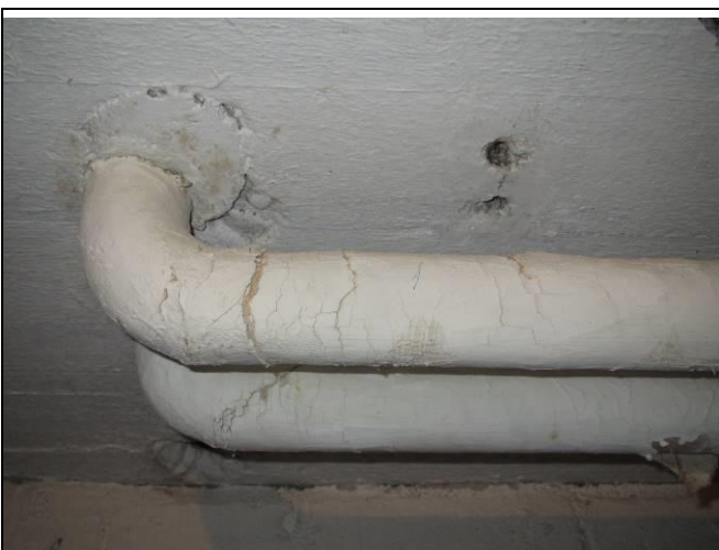
Kuva 7.5 Putkieristeet ovat halkeilleet.
