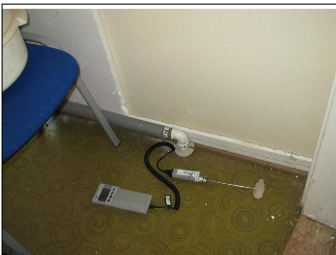
Kuva 8.7 Viiltomittaus vesivahinkoeteisen muovimatton alta
