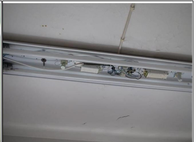
Kuva 8.12 Keittiön katossa on maalipinnan halkeilua.
