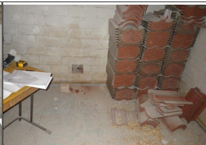
Kuva 6.2 Yleiskuva kellarin ulkoseinästä.
