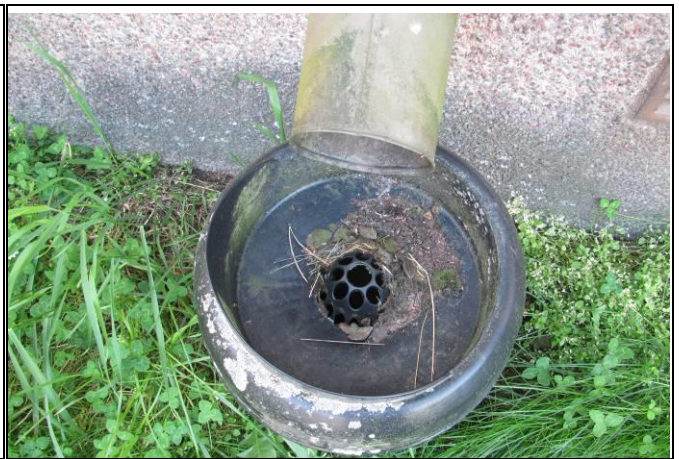
Kuva 5.2 Rännikaivo on hieman tukkeutunut.
