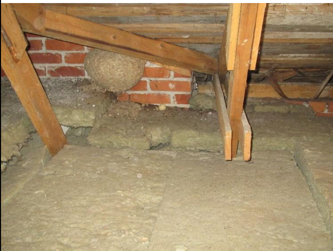
Kuva 10.3 Hylätty pesä yläpohjassa.
