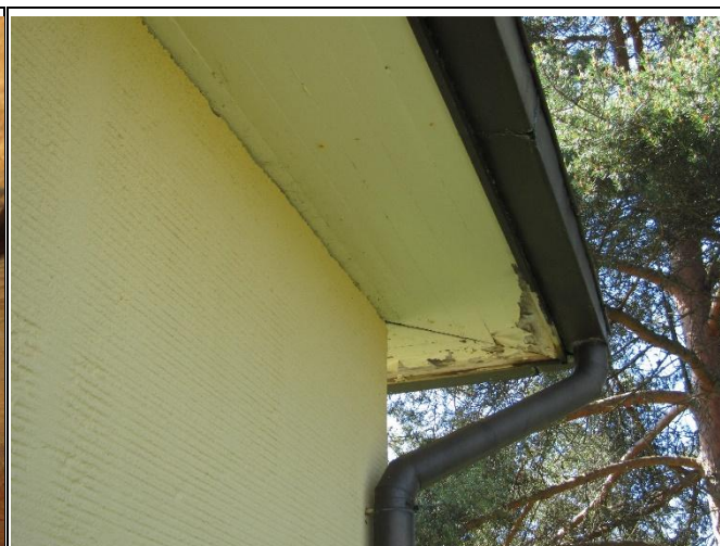
Kuva 11.10 Rästäänalusoitoitus on kosteusvaurioitunut.
