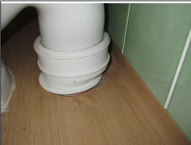
Kuva 8.11 Läpiviennit ja liitokset ovat epätiivisiä.
