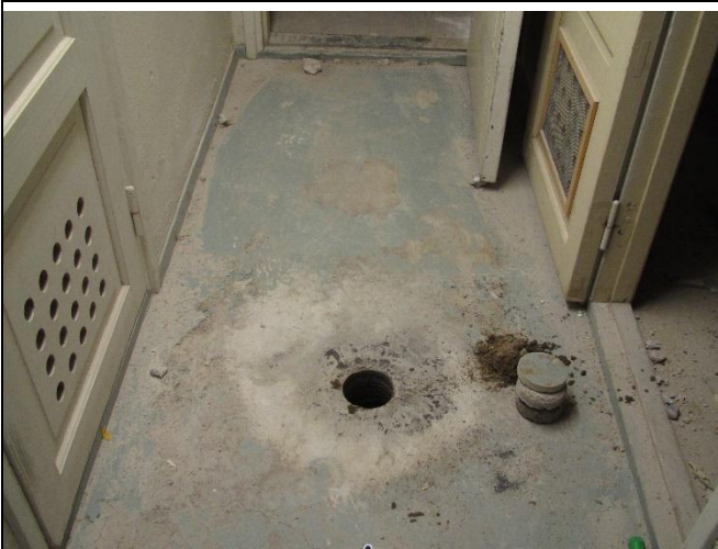
Kuva 7.1 Yleiskuva käytävän lattian maalipinnoitteesta.
