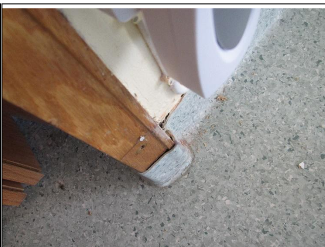
Kuva 8.8 Muovimatton ylösnosto on irti seinustasta.
